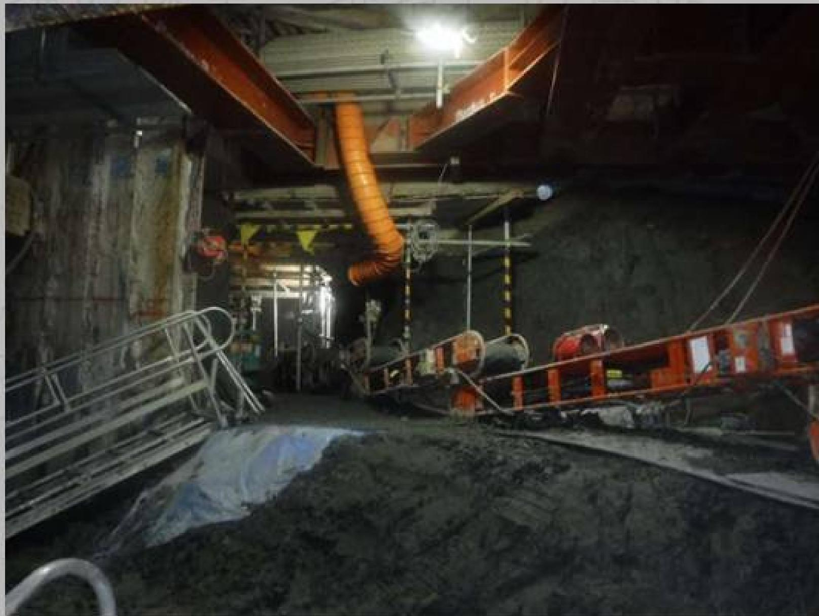
非開削工区 軌道下掘削工
