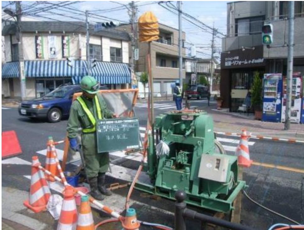
施工状況写真
