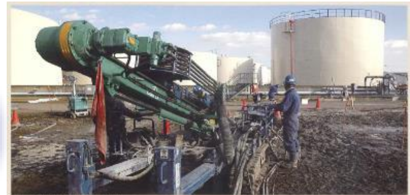
貯留タンクを回避した施工状況
