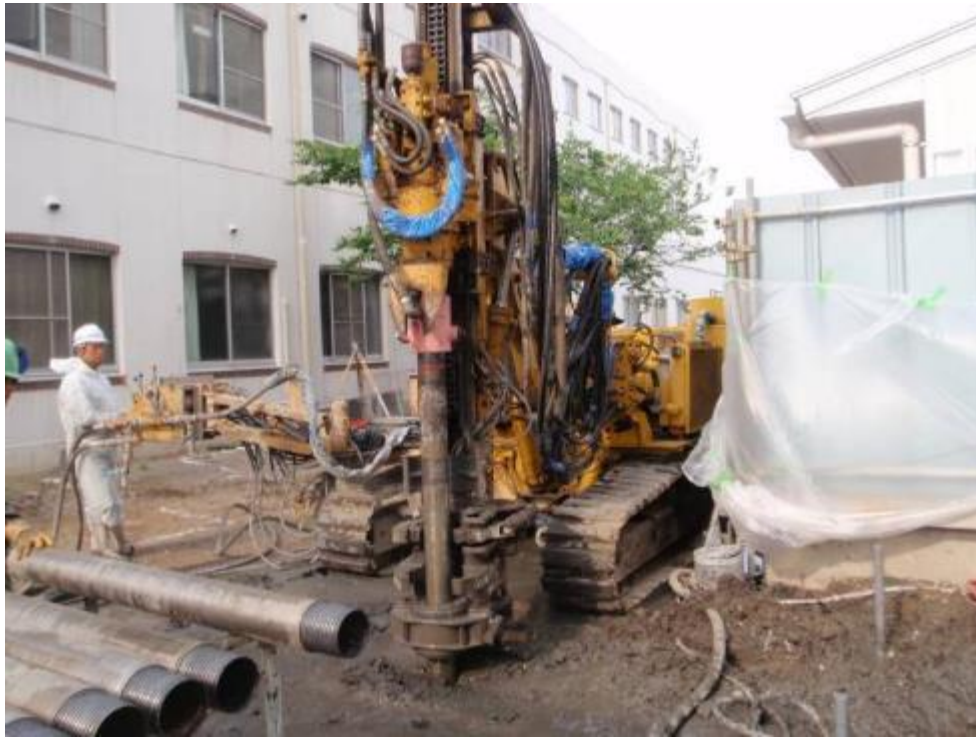
施工状況(削孔状況)写真
